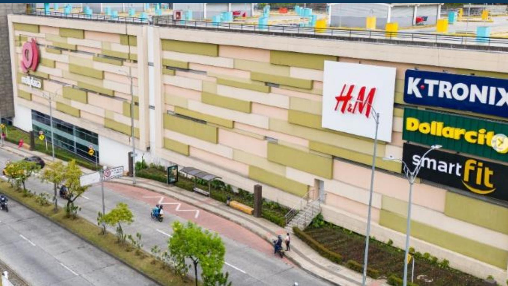
El SATE es un sistema de aislamiento térmico por el exterior, consistente en un panel aislante prefabricado, adherido al muro, cuya fijación habitual es con adhesivo y fijación mecánica.
