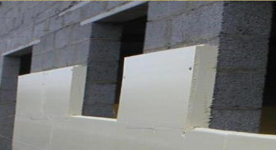
Los materiales de aislamiento térmico empleados en los sistemas SATE deben cumplir con unos requisitos mínimos con ciertas propiedades, como, por ejemplo, la estabilidad dimensional o el comportamiento a esfuerzo cortante.
